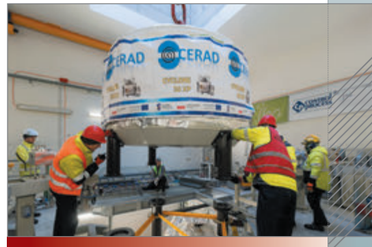
Umieszczanie cyklotronu w budynku laboratorium
